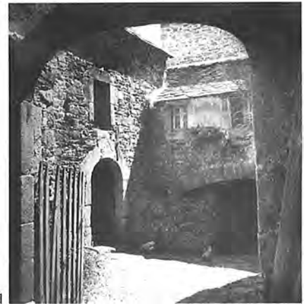
Las bòrias de Leveson
