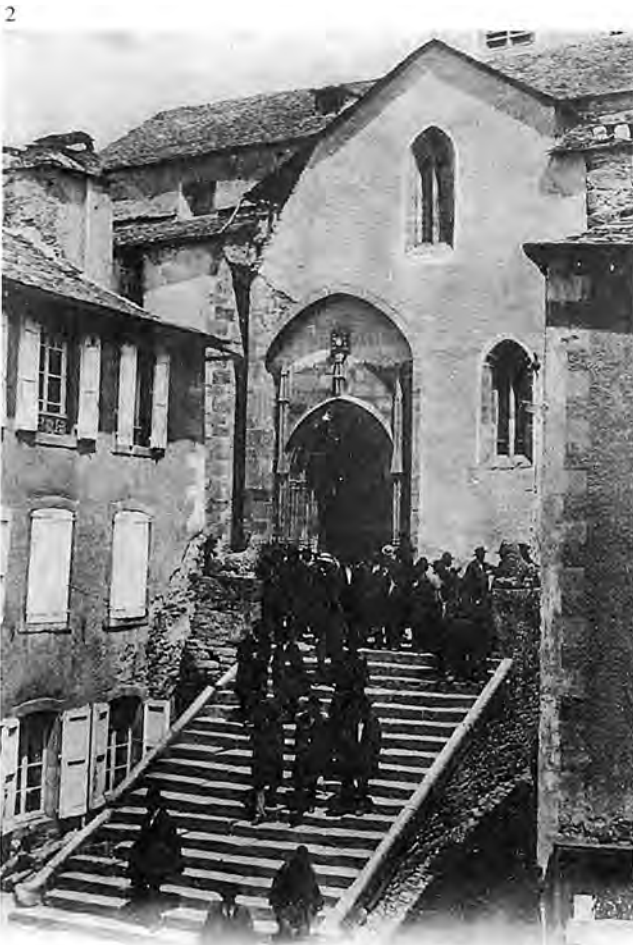
3 — SALLES-CURAN - Entrée de l'Eglise, Grand Escalier
