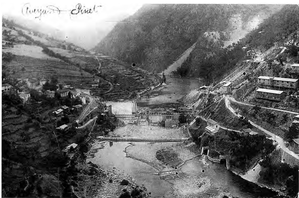
Barrage et usine de Pinet. (Coll. J. Frayssignes)
