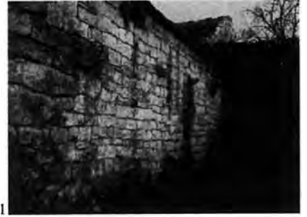
1. - Boquets supportant une canal de bois alimentant la cistèrna. (Ph. C.-P. B.)
