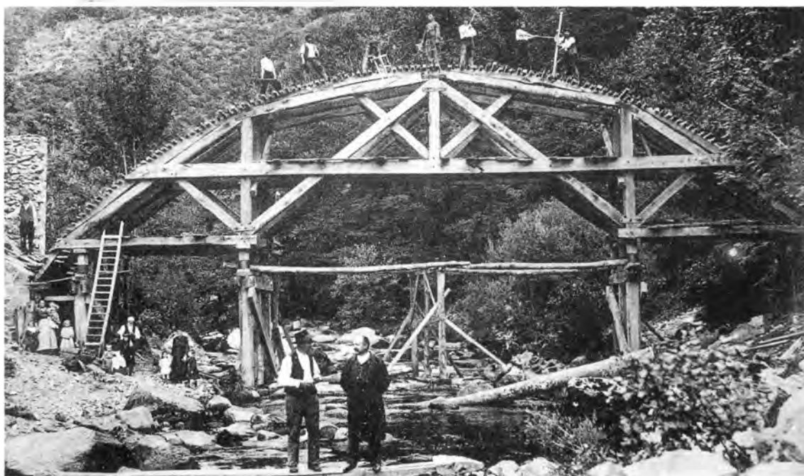
1902. Camboulas. Charles Monteillet, compagnon, meilleur ouvrier de France, bâtisseur du pont de Camboulas. (Coll. Jules Pons)
